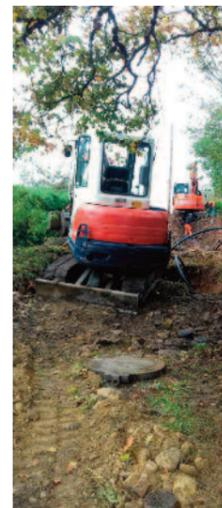
Cet automne, le Syndicat Intercommunal des Eaux de la Haute Grosne a fait procéder, sous un ciel relativement clément, au remplacement d'une partie du réseau qui alimente notre commune. La société Pétavit a ainsi enfoui 780 m de canalisations en fonte de 100mm en Rhôdes (traversée des prés du Mont-Allègre) et 480 m aux Granges où les branchements ont été adaptés pour une meilleure facilité d'interventions ultérieures.
